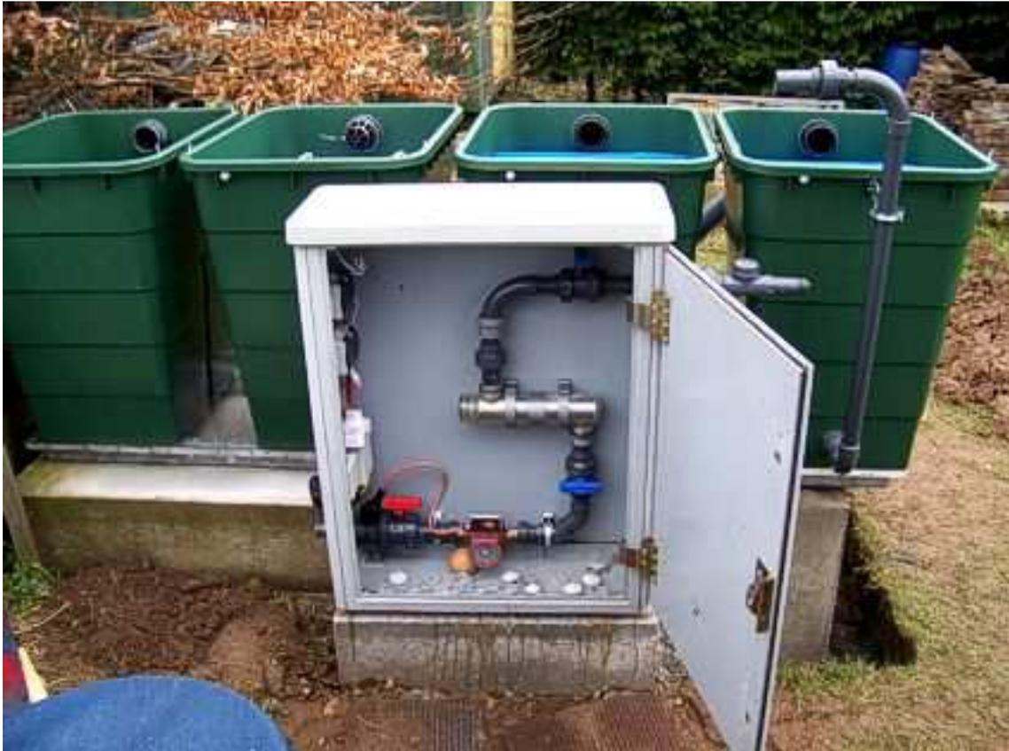
Hier sieht man die Anordnung von Pumpe und UV-C Klärer. Links am Schrank der Zulaufanschluss vom Teich, dann ein Abstellhahn, Pumpe, Abstellhahn, UV-C Klärer, Abstellhahn und rechts Außen der Anschluss zum Filter. Wenn am Ende alles angeschlossen ist und der Wasserkreislauf geschlossen ist, können die Bakterien in der Filteranlage ihre Arbeit verrichten. Das Ergebnis kann sich sehen lassen:
