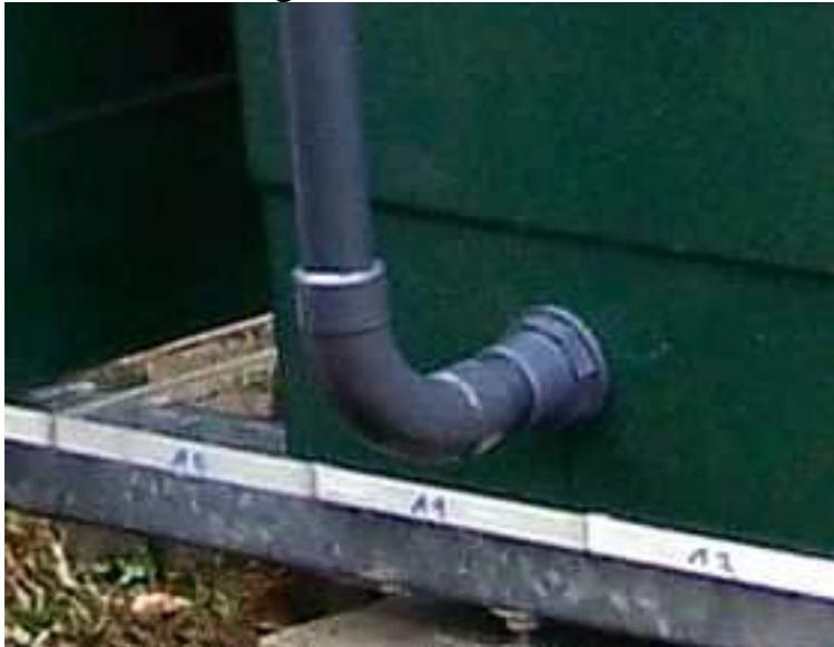
Alle Filtertonnen werden auf einer genauen Ebene gestellt, damit keine Tonne überlaufen kann. Von Oben, etwas unter dem Rand der Tonne, hab ich ein 100mm PVC Rohr nach Unten zur nächsten Tonne montiert. So kann das Teichwasser immer von Unten nach Oben und von einer Tonne zur anderen fließen.
